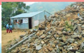
いまだ撤去されないガレキ
